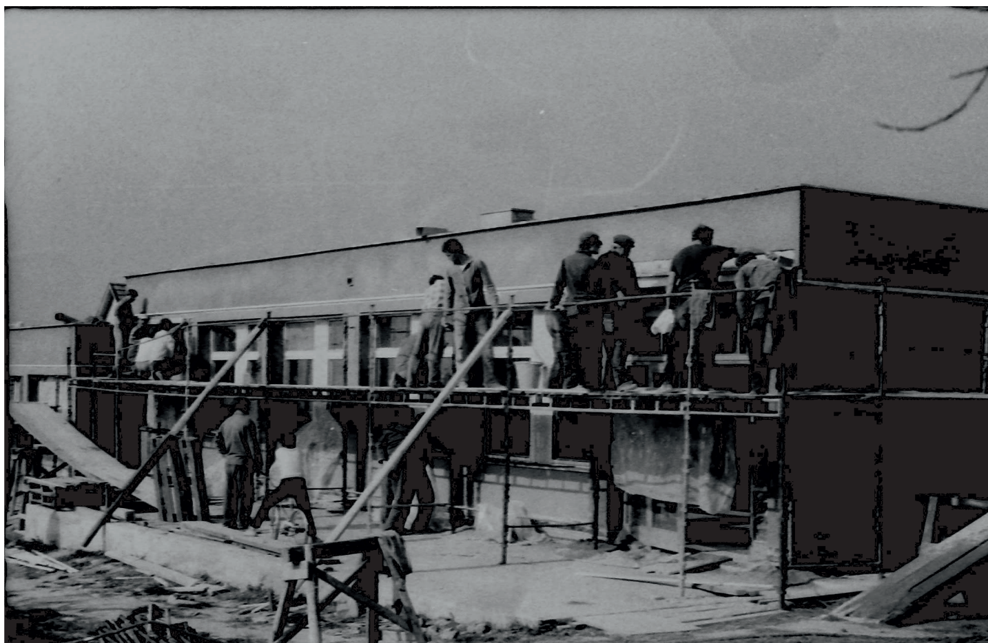
Brigáda pri výstavbe škôlky
